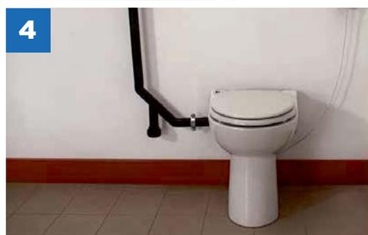
Collegare il WC Sanicompact a una presa elettrica da 230 V.
