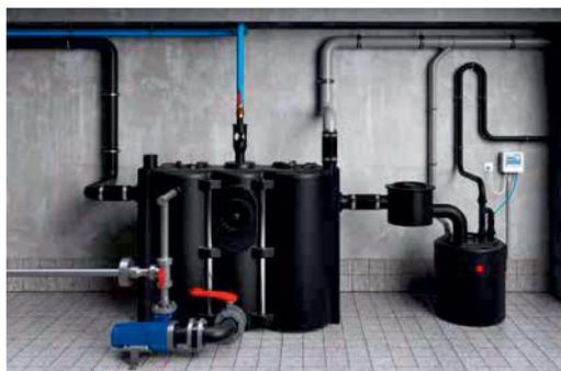
In conformità alla norma DIN 4040-100 è obbligatorio impiegare un set per piccolo compressore per l'iniezione dell'aria (n. art. ZPS14894) e un dispositivo di allarme indipendente dalla rete elettrica (n. art. SANNETZALARM) nelle stazioni di sollevamento da utilizzare a valle di un degrassatore.
