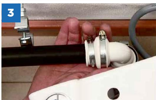
Collegare il gomito di scarico del Sanicompact al vostro tubo in PVC e congiungerlo allo scarico principale.
