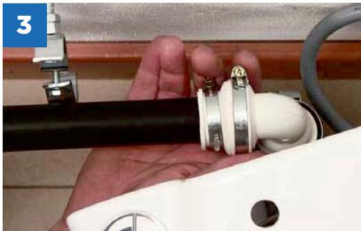
Schließen Sie den Ablaufbogen des Sanicompact an Ihr PVC-Rohr an und verbinden Sie ihn mit Ihrem Hauptabfluss.
