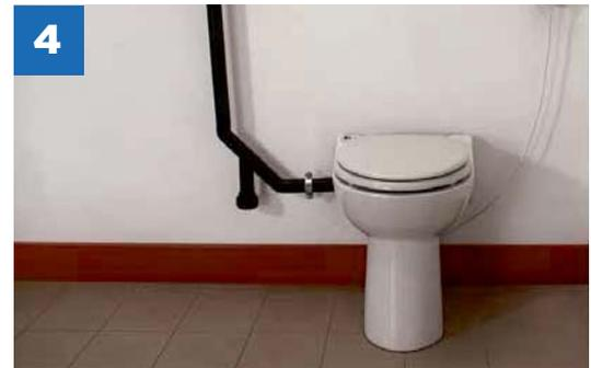
Schließen Sie das Sanicompact-WC an eine 230 V-Steckdose an.
